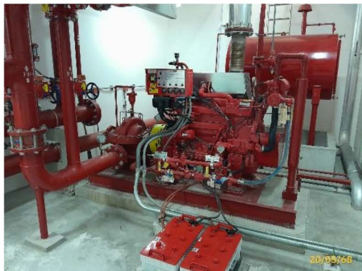
เครื่องปั้มน้ำดับเพลิง ชั้นห้องเครื่องชั้นใต้ดิน อาคาร X
