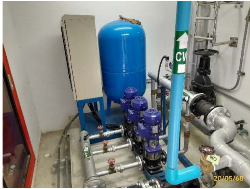
Booster Pump อาคาร X
