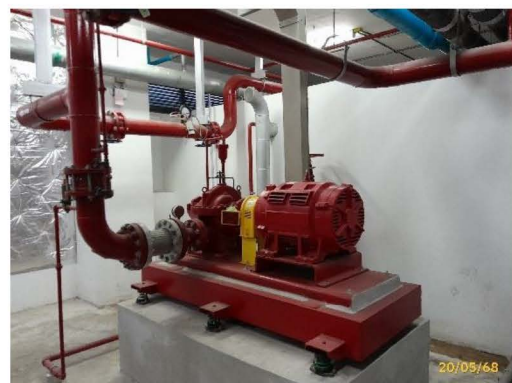
เครื่องปั้มน้ำดับเพลิง ชั้น 23 ชั้นห้องเครื่อง อาคาร X
